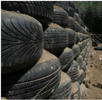
Imagen 8 Muro de Neumáticos
