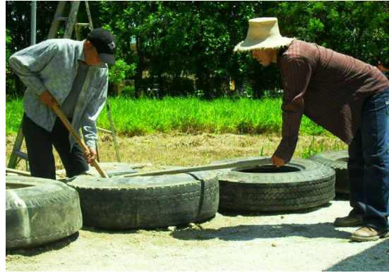
Imagen 43 Utilizacion de la barra y almadana en compactación
