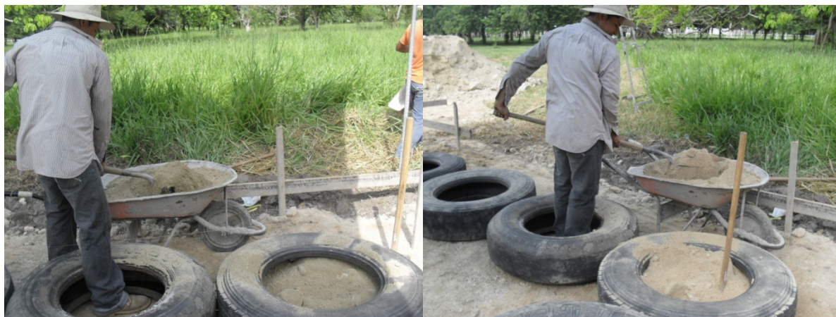
Imagen 41 Colocación del material
