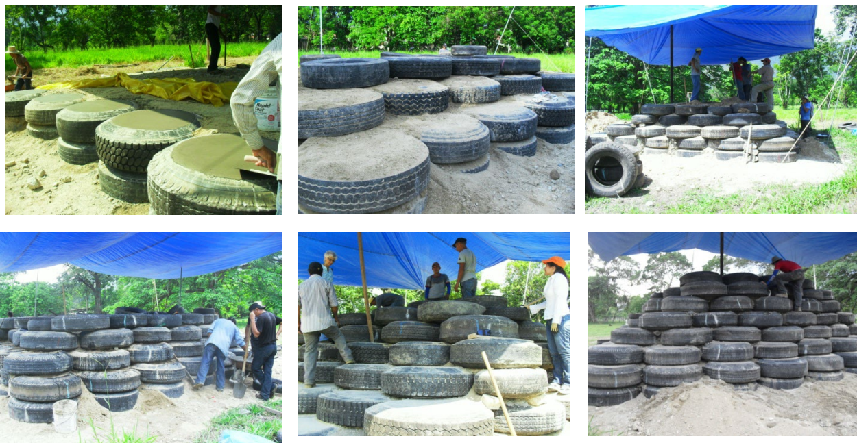
Imagen 53 Progreso de Construcci3n
