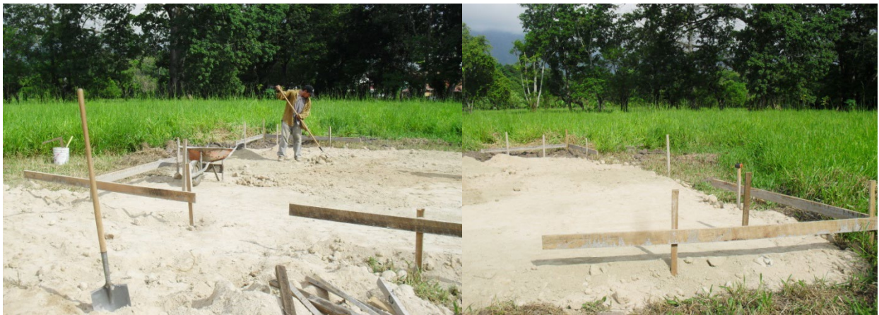
Imagen 23 Niveletas en Terreno
