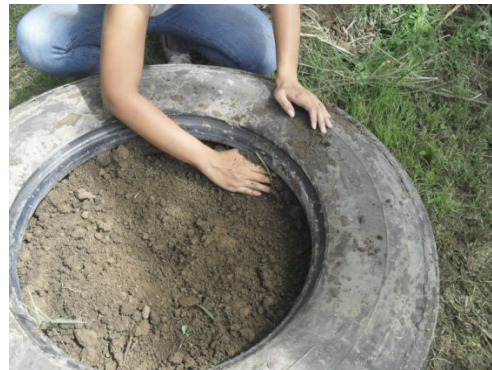
Imagen 18 Compactación del Neumático
