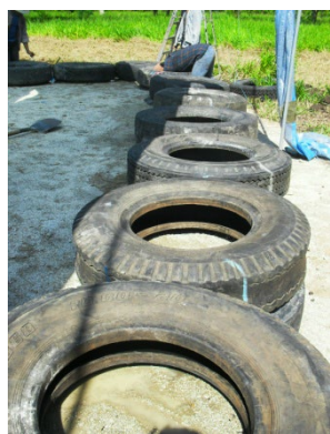
Imagen 49 Segunda fila de neumáticos
