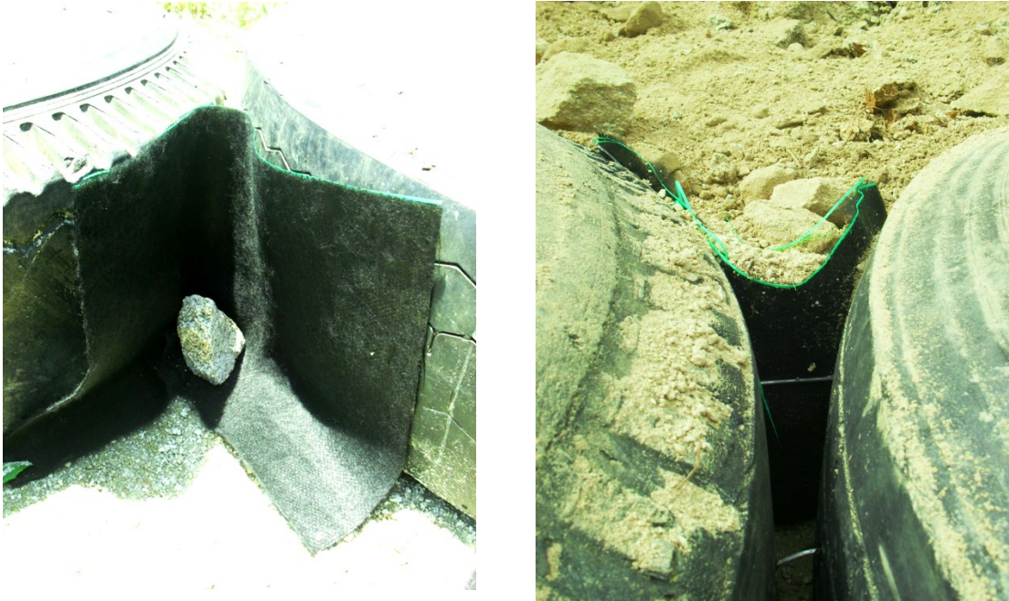
Imagen 46 Geotextil en estructura
