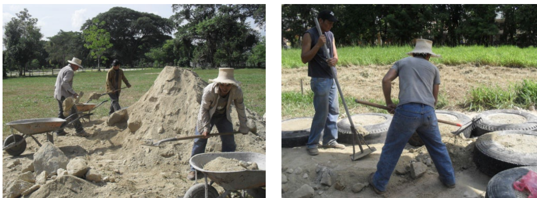
Imagen 47 Ejecucion del relleno del área interna de estructura
