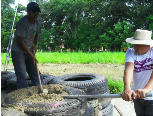
Imagen 43 Utilizacion de la barra y almadana en compactación
