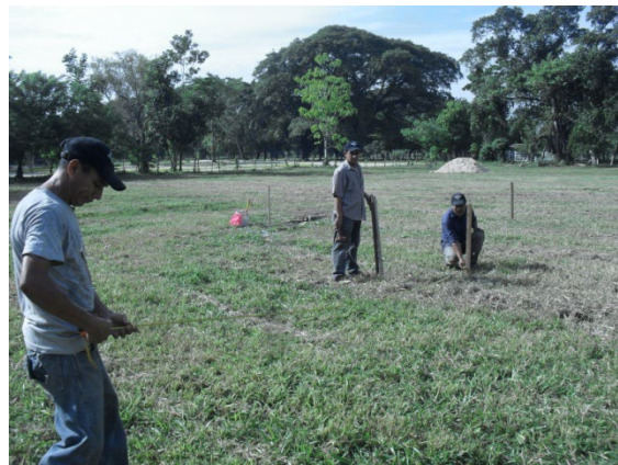
Imagen 20 Medición del terreno
