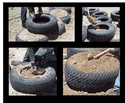
Imagen 12 Proceso de Rellenado (Reynolds, Earthship Global Volume Operation 1 Tire Work, 2011)
