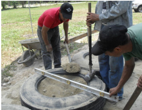
Imagen 44 Nivelado de compactación
