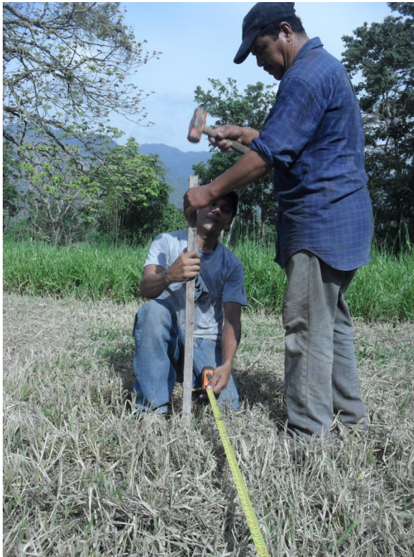
Imagen 21 Colocación de Estacas
