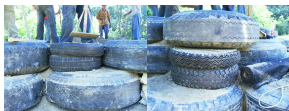
Imagen 54 Utilizaci3n de neumáticos de distintos tamaños
