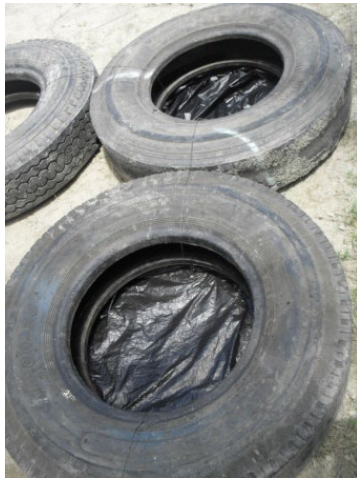
Imagen 19 Plástico para evitar capilaridad
