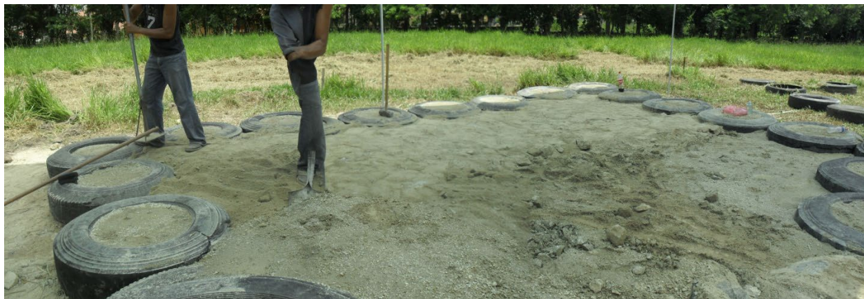
Imagen 48 Panorámica de área interna rellena de material selecto.
